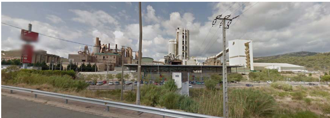
Imatge de la cimentera des del ramal de connexió entre l'antiga NII i la N340 (des del punt vermell que hi ha a l'ortofoto cap a l'W/SW).
