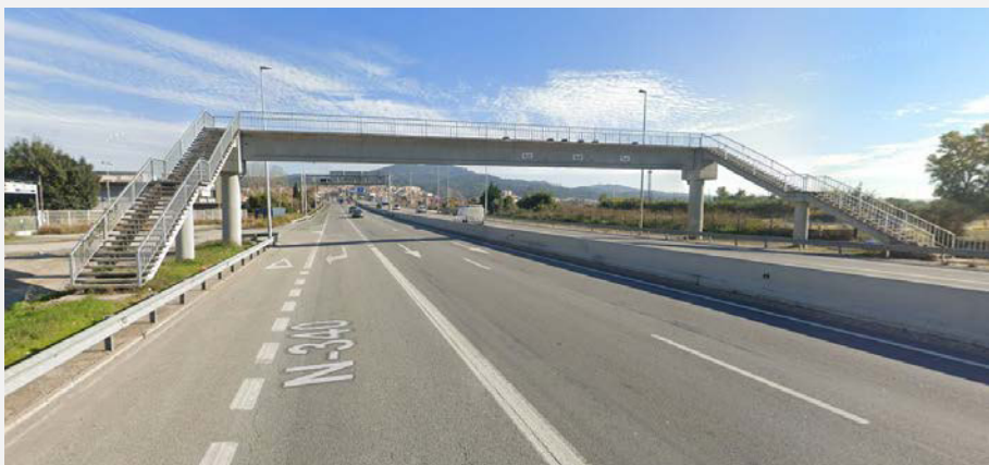
Figura 18. N-340, a l'alçada del pont de connexió amb Molins de Rei
