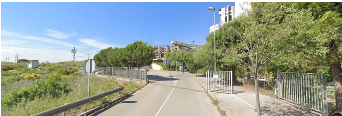
Vista de l'accés rodat a l'aparcament de l'estació de Quatre Camins. Font: Google Maps (2019).
