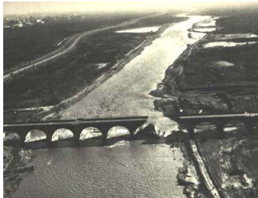
Figura 10.7: Imatge del pont de Carles III, el 1971, derruït. Es pot comprovar com el Llobregat estava molt crescut i havia inundat molts camps de la Vall Baixa. Font: Solé i Sabarís (1974:vol. III, 54).
