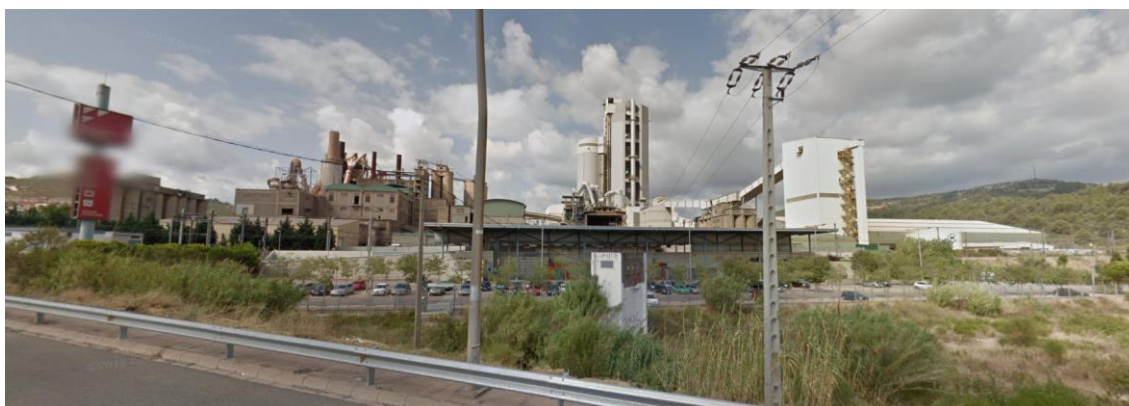
Imatge de la cimentera des del ramal de connexió entre l'antiga NII i la N340 (des del punt vermell que hi ha a l'ortofoto cap a l'W/SW).
