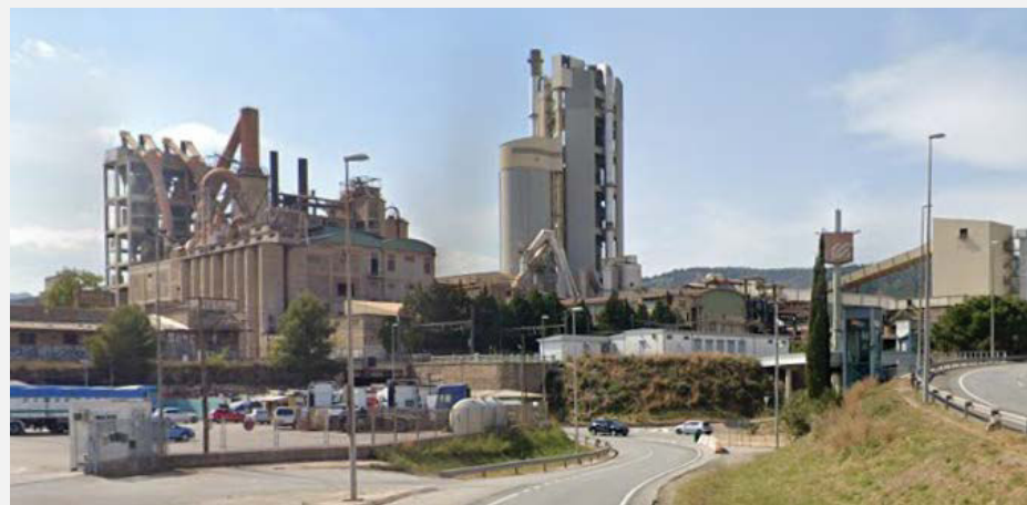
Figura 14. Absència d'itinerari per a vianants. Ramal d'accés a la BV-2002
