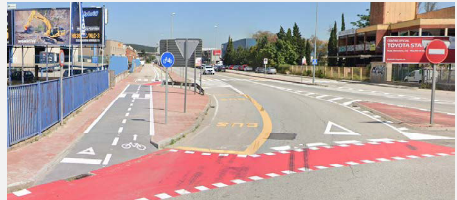
Figura 16. Carril bici segregat en calçada a la N-II a Pallejà
