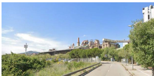
Vista des del vial d'accés a l'aparcament.
