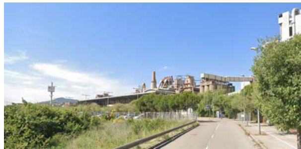
Vista des del vial d'accés a l'aparcament.
