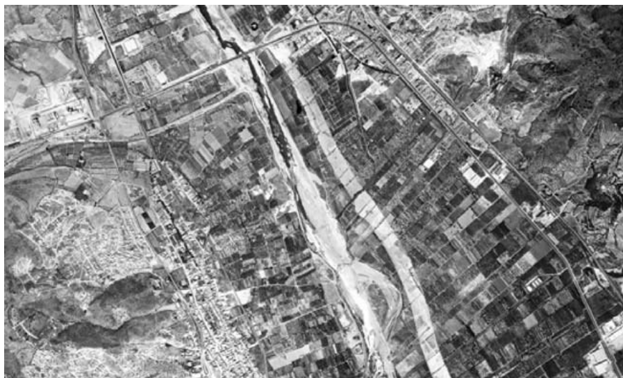
Figura 10.9: S'observa la construcció de l'AP-2 i l'impacte que representa en els camps de la riba.
