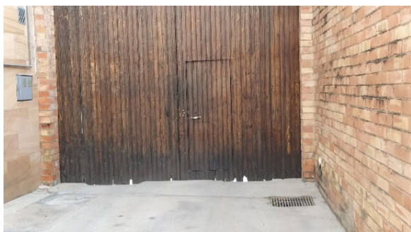
Reixa pluvial amb desaigua al c/ Nou
