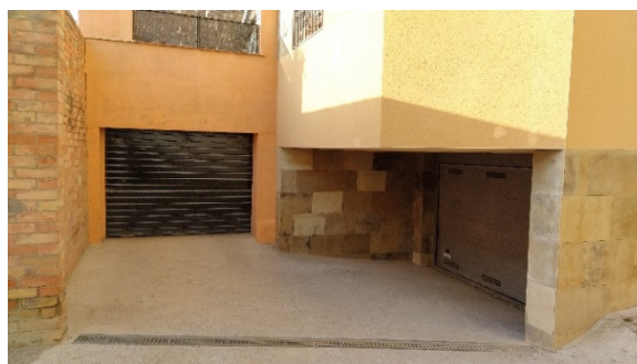
Reixa pluvial aparcament finca c/ R de Casanova, 81
