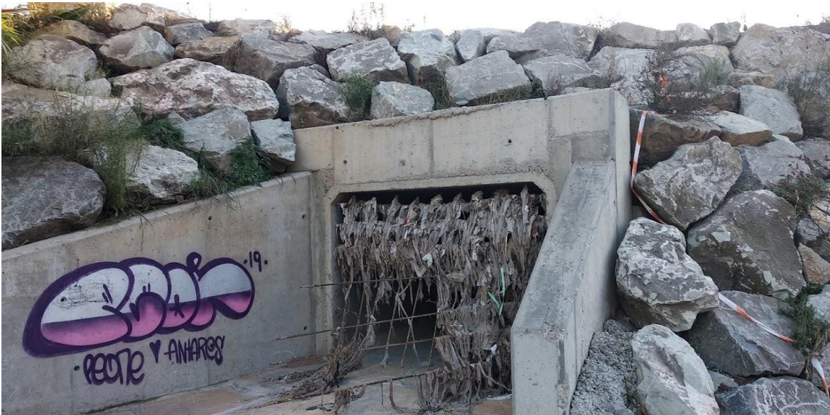
Imatge 22: Sortida a medi del col·lector de la xarxa unitària de sanejament aigües amunt del pont del Ferrocarril de la Generalitat de Catalunya
